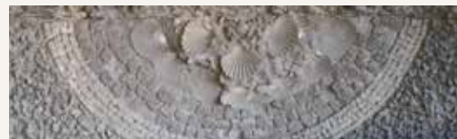
Fig. 2 - Particolare prima e dopo la pulitura dell'ICR di un'area campione della decorazione. Fig. 2 - Before and after the ICR cleaning of a sample area of the decoration.
